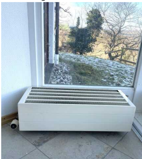
Zusatzheizkörper zur Fußbodenheizung
